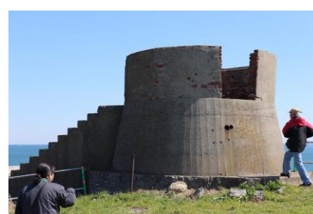
▲防空指揮所といわれている建物
