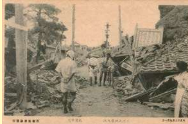
館山における関東大震災の被害を記録した絵はがき
